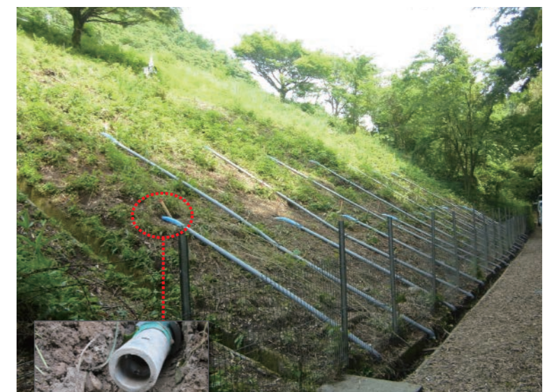
排水管設置状況 (L=9m~11m@3m)
