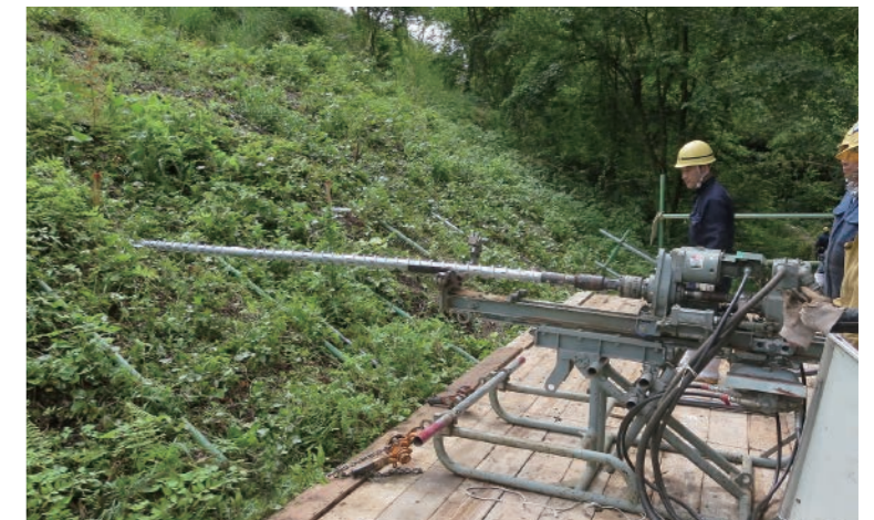
スパイラル羽根付き鋼管の挿入状況
